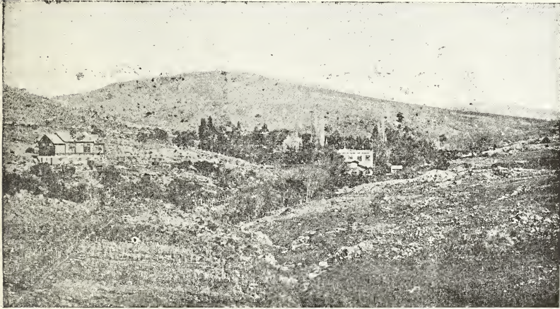
Departamento de Minas—Establecimiento del Agua «Salus»
